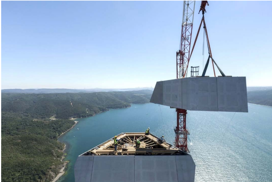
Leichter bauen: Hier schwebt ein Fassadenelement mit textiler Bewehrung des Tectextil-Ausstellers solidian an die Spitze der Yavuz-Sultan-Selim-Brücke – 320 Meter über dem Bosporus / Quelle: Fibrobeton
